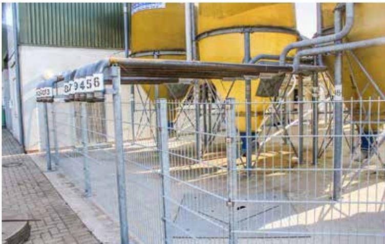
Die Verlängerung der Anschlüsse ermöglicht ein Befüllen der Futtersilos, ohne den eingefriedeten Bereich zu betreten. Fotos (2): Dr. Onno Burfeind
