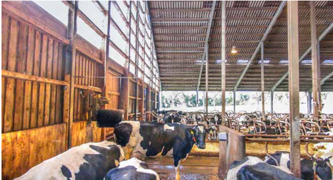
Der Dachaufbau inklusive Lichtplatten kann einen erheblichen Einfluss auf den Wärmeeintrag in den Stall haben.
