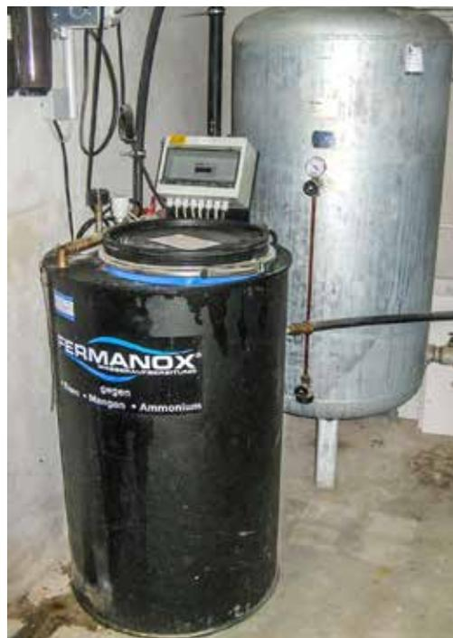
Bei der unterirdischen Enteisung im Brunnen wird Wasser in einem Zwischenbehälter mit Sauerstoff angereichert und zurück in den Brunnen geleitet.
