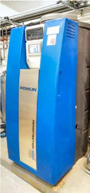
Beim Verfahren der Wasserenteisung in oberirdischen Behältern wird das Brunnenwasser in Behältern mit Filtermaterial belüftet. Das Eisen fällt aus und bleibt im Filtermaterial zurück.
