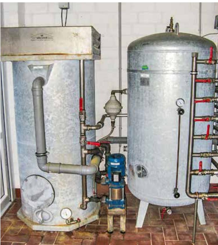
Bei der Auswahl des Standortes für die Wasserenteisungsanlage ist zu beachten, dass die Schwitzwasserbildung im Pumpenraum bei einwandigen und verzinkten Behältern zunimmt, dass Geräusche entstehen und der Raum frostfrei sein muss.
