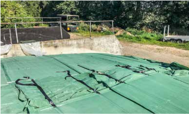
Abdecksysteme wie das Silage-Safe-System erleichtern die Arbeiten beim Abdecken. Die Gewebbahnen werden mit Gurten verspannt. Nach Abklingen der Gashauben und dem Sacken des Silostapels ist ein Nachspannen erforderlich. An den schrägen Stirnseiten werden Kiessäcke oder Matten zur Beschwerung verwendet. Fotos: Dr. Susanne Ohl
