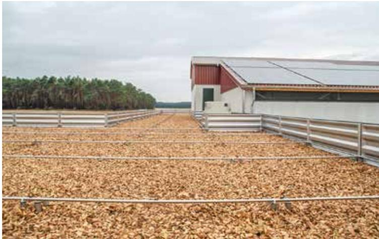
Biofilter zur Abluftreinigung
