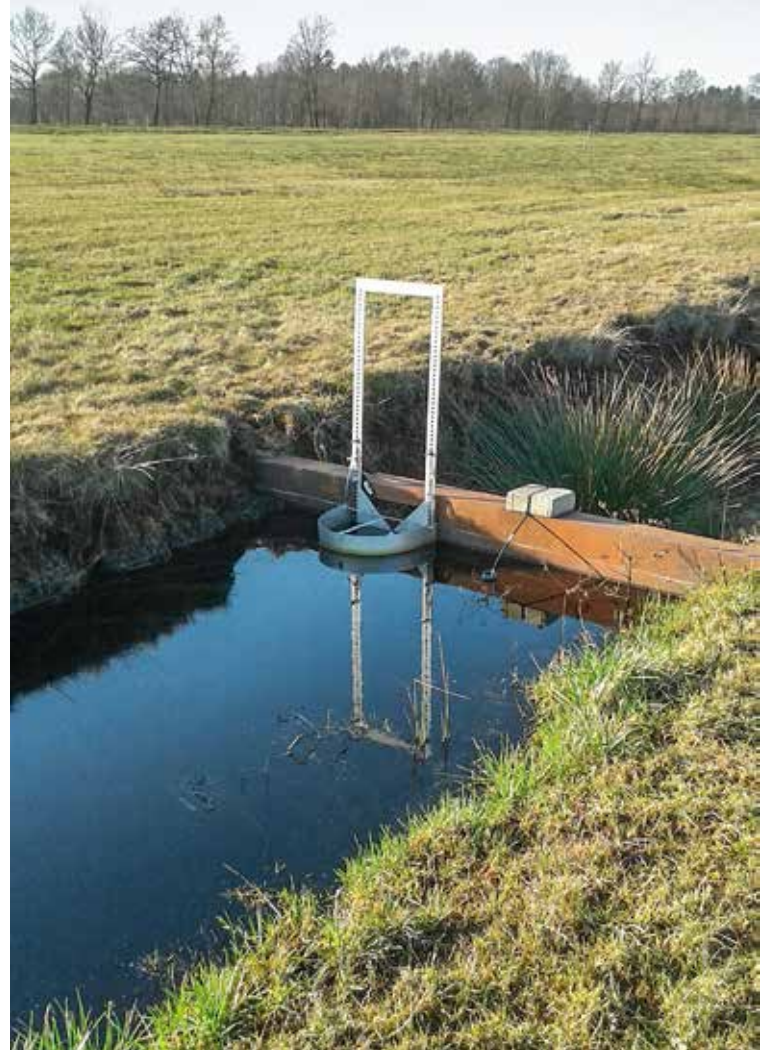
Ein höhenverstellbares Stauwehr hält Wasser im Graben.
