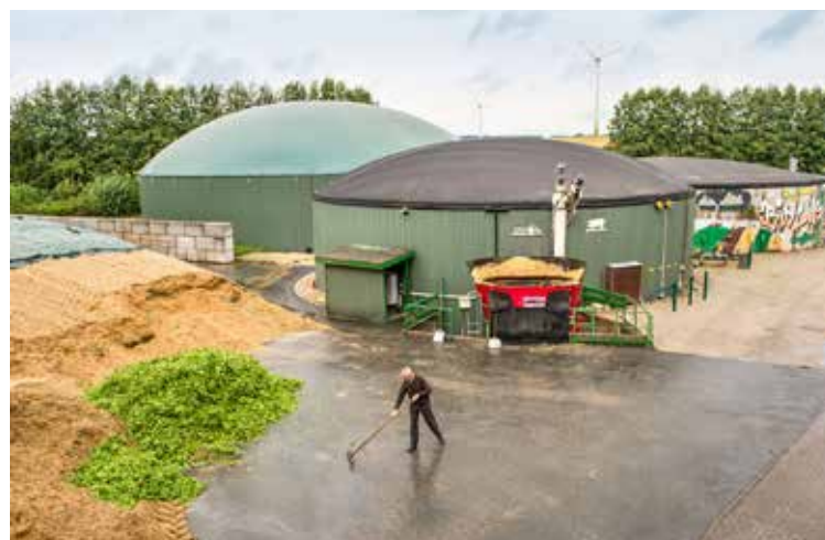
Biogasanlagen haben große versiegelte Flächen, auf denen nach Regenereignissen organisch belastetes Wasser anfallen kann. Dafür wurde im Projekt BGA-Flexbio eine kostengünstige Technik zur Aufreinigung entwickelt. Foto: Fachagentur Nachwachsende Rohstoffe/D. Hagenguth
