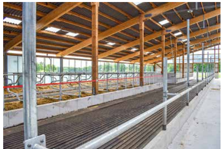
Laufgang mit Gummibodenbelag
