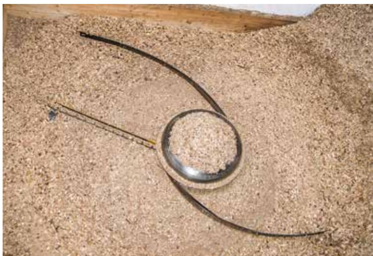
Die Hackschnittel werden von einem Ausstragkreisel im Vorratsbehälter auf die Zuführschnecke gerührt und bedarfsgerecht zum Kessel gefördert.
