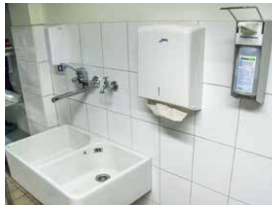
Im Stalleingangsbereich oder in der Milchammer sollte ein funktionierendes Waschbecken mit Seife und Handdesinfektion installiert sein, damit Mitarbeiter und Dienstleister schnell und einfach die Hände und Gerätschaften reinigen können.
