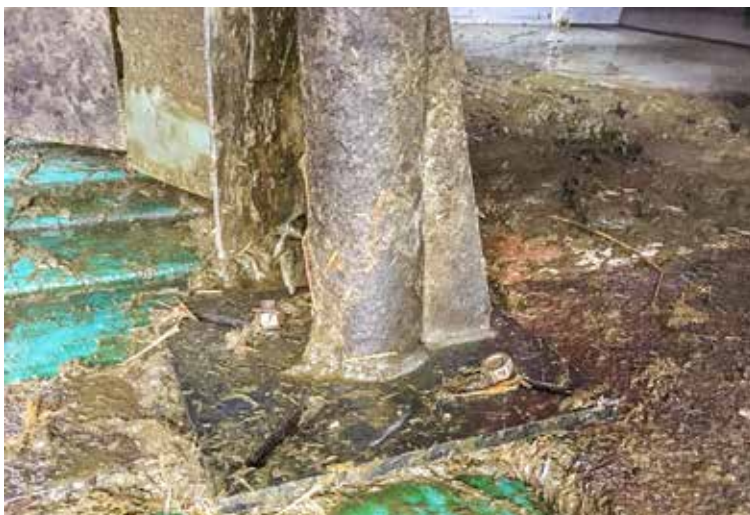
Hervorstehende Schrauben im Boden sind „Klauenfresser“.
