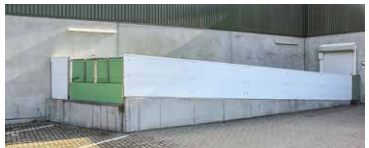
Die Einfriedung der Futtersilos und der Verladerrampe stellen die Mini-mallösung einer Betriebseinfriedung bei einzelnen Schweineställen im Rahmen einer Insellösung dar. Die Markierungen erleichtern den Fahrern das Rangieren zur Verladung. Fotos: Dr. Onno Burfeind
