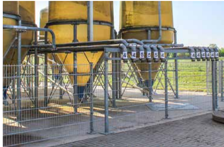
Die Siloanschlüsse sind ohne Befahren des Betriebsgeländes durch den Futterlieferanten zu erreichen. Dies erhöht die Biosicherheit.
