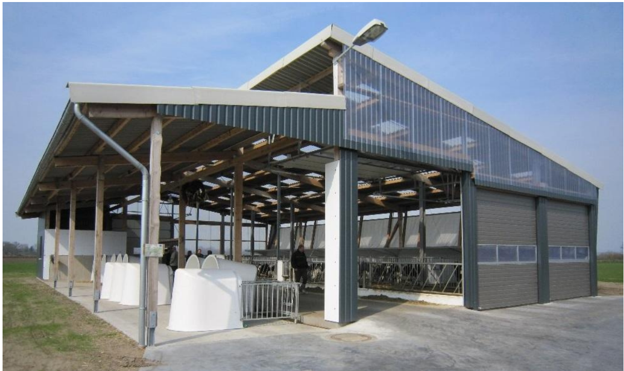
Abb. 10: Holsteiner Kälberstall in der klassischen Version mit Gruppenbuchten auf der einen und Einzeliglus auf der anderen Seite des Futtertisches
