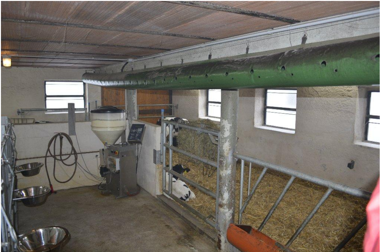
Abb. 21: Schlauchlüftungen sorgen für eine kontinuierliche Frischluftzufuhr mit Windgeschwindigkeiten von max. 0,2 m/s im Tierbereich
