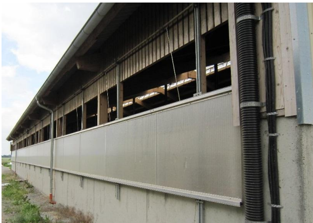
Abb. 20: Das Hubfenster lässt auch im geschlossenen Zustand Licht in den Stall und kann bei Bedarf nach unten geschoben werden.
