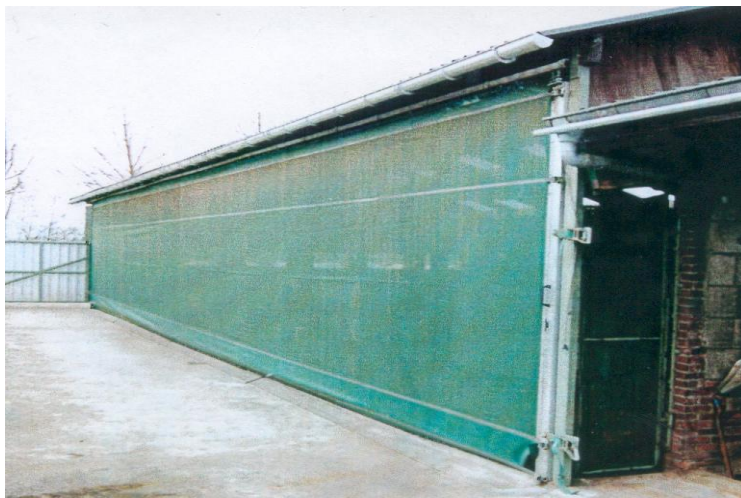
Abb. 18: Windschutznetz zum seitlichen Aufschieben
