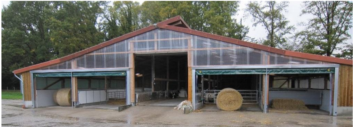
Abb. 11: Holsteiner Kälberstall in der gespiegelten Version mit Gruppenbuchten auf beiden Seiten des Futtertisches
