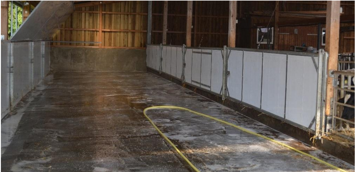
Abb. 12: Die Aufkantung im Holsteiner Kälberstall ermöglicht es, dass nach dem Entmisten bei voll besetztem Stall die Entmistungsachsen gewaschen und desinfiziert werden können.
