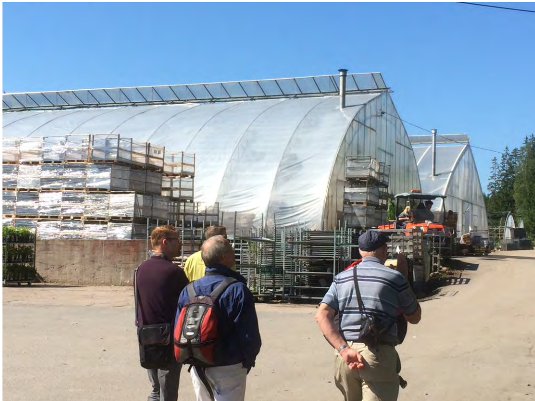
Abb. 4: Typische Bauweise von Folienhäusern in Skandinavien, die das problemlose Abgleiten von Schnee begünstigen, aufgenommen im Gartenbaubetrieb Puutarha Tahvoiset
